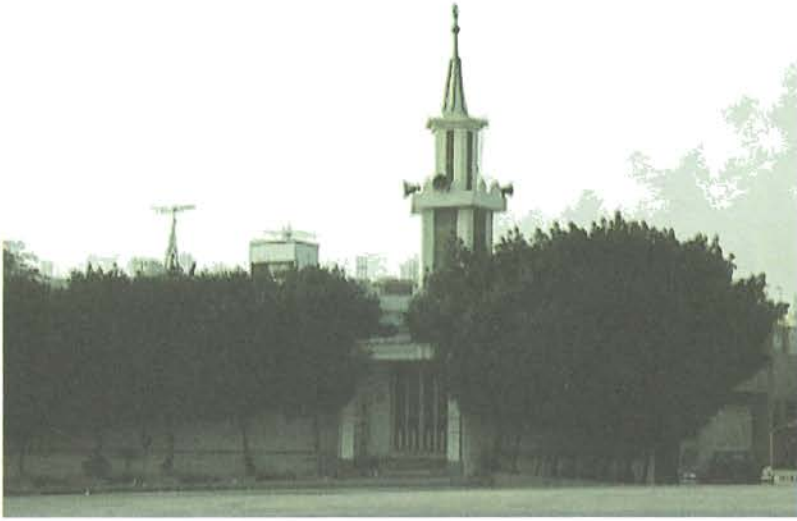
مسجد الحريشة على الشارع الرئيسي
