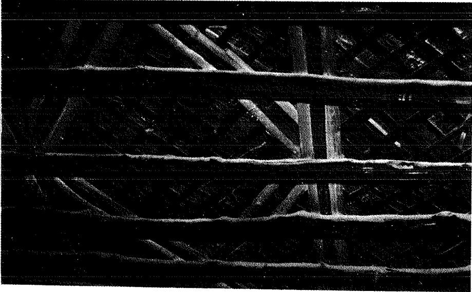
صورة تمثل عملية حمل السقف بواسطة السيقان الخشبية (الجنديل)
